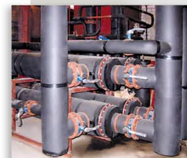
Пример объединения подогревателей в блоки
